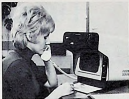
afb. 14. Beeldtelefoon van Grundig, anno 1968, met kiesschijf en handset.
